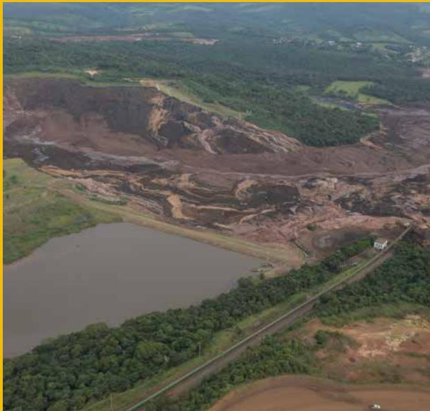
Banalizar a vida é manter ativa uma barragem feita pelo método de construção da B1, de alteamento a montante, que é o mais barato e menos seguro. Nele, a barragem ganha novos degraus, feitos com o próprio rejeito, material instável que a deixa mais sujeita a liquefação, como ocorreu em Brumadinho e em Mariana, que colapsou em 2015, matando 20 pessoas.
